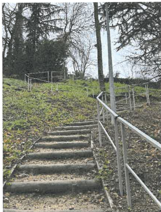
Installation d'une main-courante entre la place Pic et le chemin du Mois de Mai
