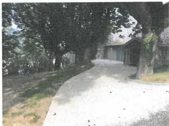
Réfection de la toiture du garage à Beauregard
