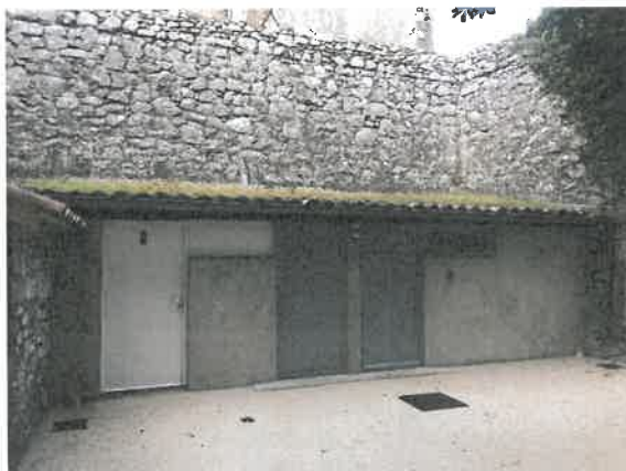
Installation des sanitaires au Château
